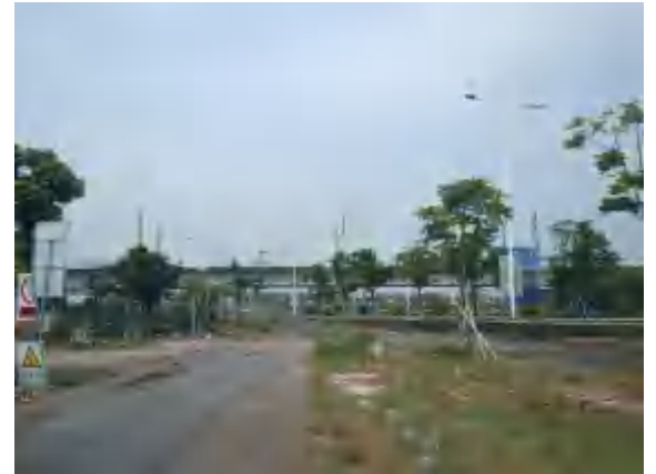
电缆沟沿线植被恢复
