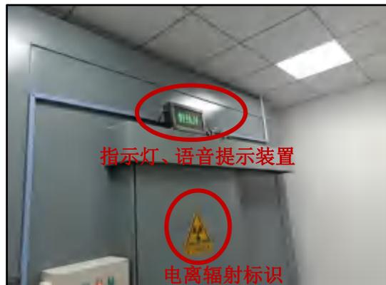
④门-机-灯连锁装置：工件进出防护门设有门-机-灯连锁装置，工件进出防护门关好后 X 射线探伤机才能出束进行探伤作业，探伤机工作过程中，工件进出防护门一旦被打开探伤机立即停止出束。
