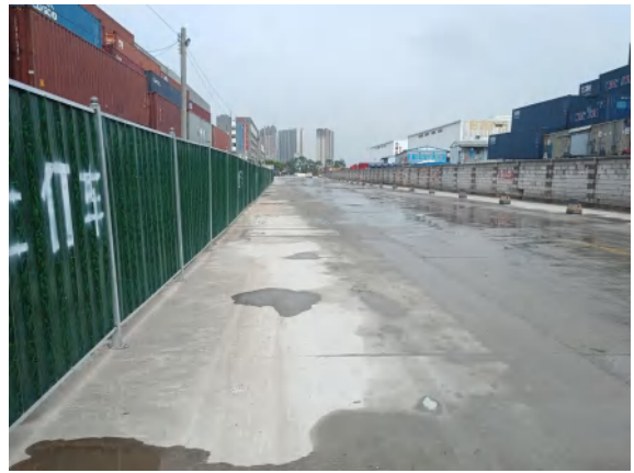
电缆沟路面硬化
