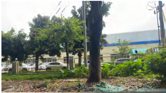
电缆沟上方植被恢复
