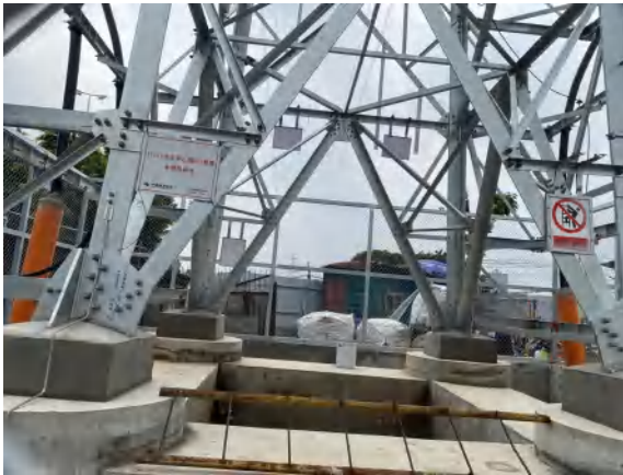
新建电缆终端塔塔基下方平整硬化
