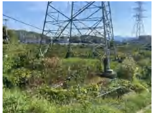
220kV 川宏 4PA1 线、川山 4PA2 线 #69 塔基绿化
