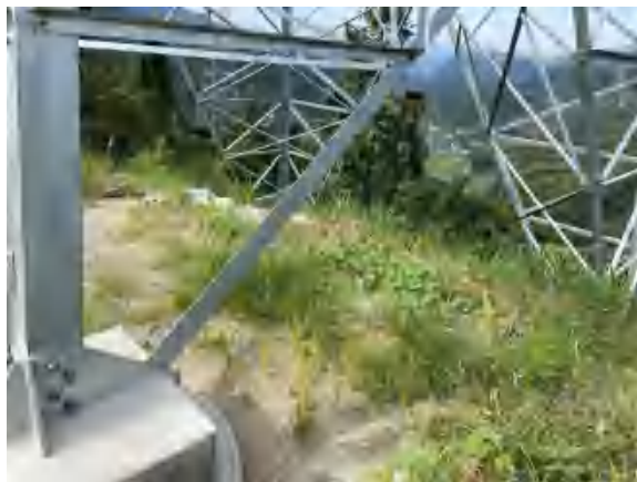
220kV 川睦 4PA3 线、川田 4PA4 线 #29 塔基恢复
