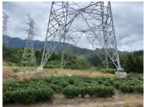
220kV 剑松 4PA5 线、剑阳 4P46 线 #149 塔基周边绿化恢复
