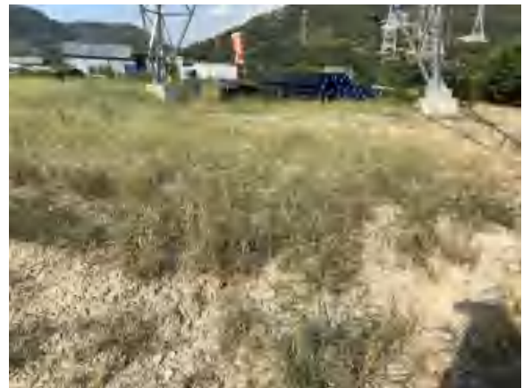
牵张场迹地恢复 2
