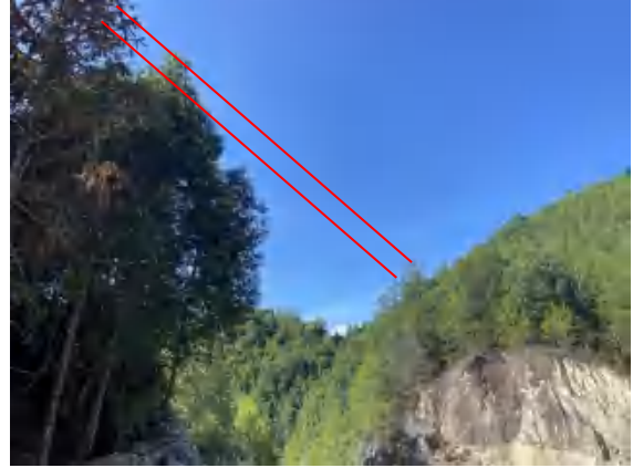
丽西~松阳 220kV 线路工程 沿线现状 2 (双回段)
