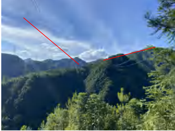
丽西~松阳 220kV 线路工程 沿线现状 1 (单回并行段)
