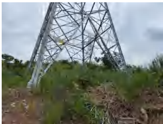
220kV 剑松 4PA5 线、剑阳 4P46 线 #150 塔基周边绿化恢复
