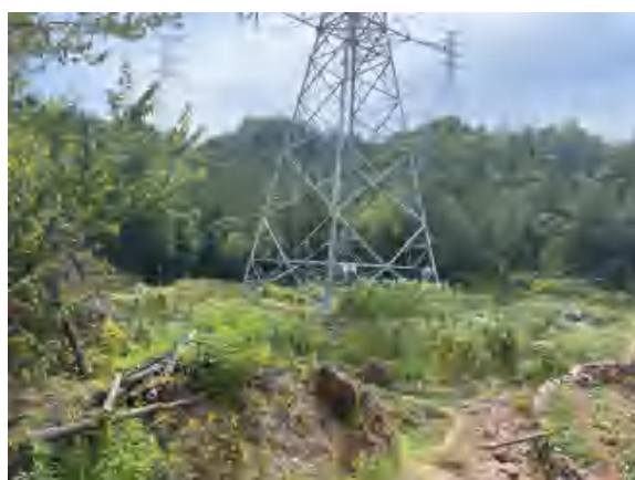
220kV 睦溪 2Q74 线、睦鹤 24R9 线#1 塔 基复耕
