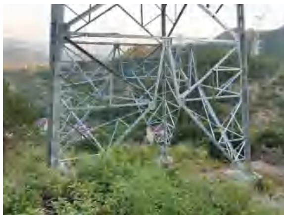
220kV 万松 4P23 线、万阳 4P24 线 #11 塔基恢复
