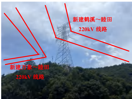
万象~鹤溪 \pi 入睦田变 220kV 线路工程 沿线现状 1 (万象~鹤溪线路开口处)
