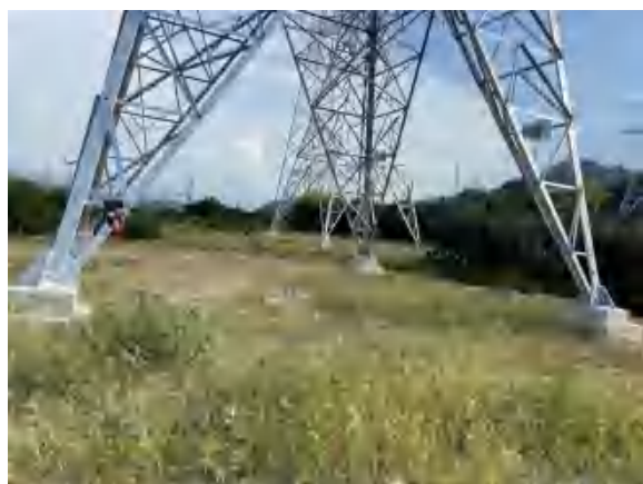
220kV 象河 4P25 线、象阳 4P26 线 #7 塔基恢复
