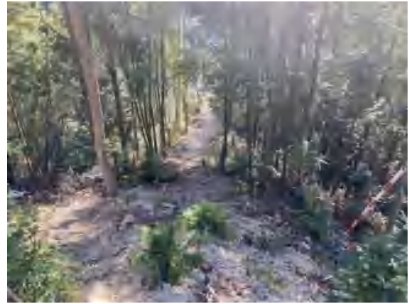
施工临时人抬道路 2
