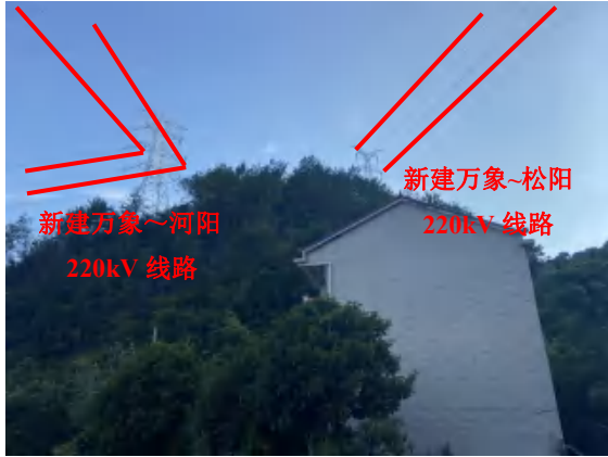
万象~松阳、万象~河阳 220kV 线路换接工程
