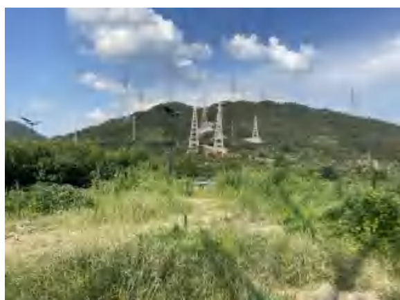
万象~松阳、万象~河阳 220kV 线路换接 工程线路沿线植被恢复
