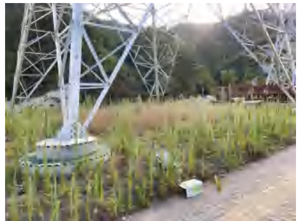
220kV 川睦 4PA3 线、川田 4PA4 线 #1 塔基恢复
