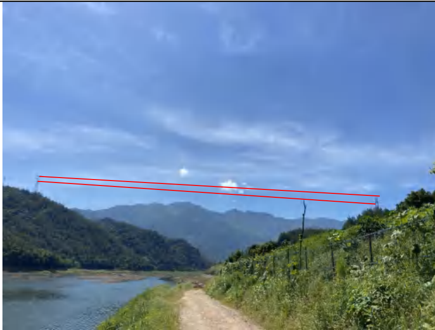
图8-1 本项目220kV川睦4PA3线、川田4PA4线#8~#9塔段一档跨越水域
