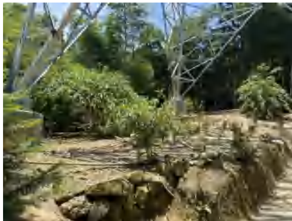
220kV 川宏 4PA1 线、川山 4PA2 线 #27 塔基绿化
