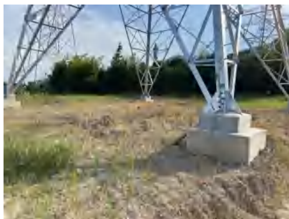
220kV 万松 4P23 线、万阳 4P24 线 #7 塔基恢复
