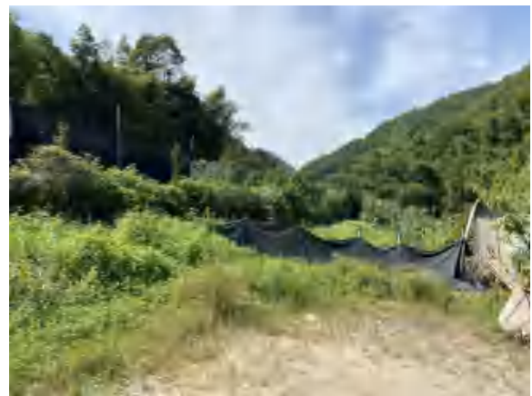
施工临时材料堆放场地 2
