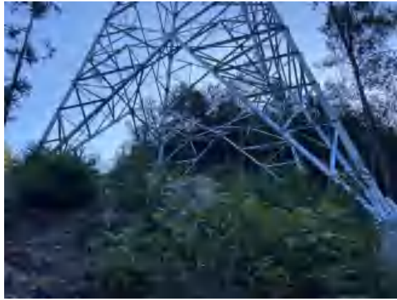
220kV 剑松 4PA5 线、剑阳 4P46 线 #63 塔基周边绿化恢复
