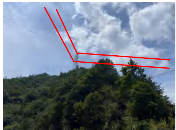
万象~鹤溪 \pi 入睦田变 220kV 线路工程 沿线现状 2 (鹤溪~睦田 220kV 线路)
