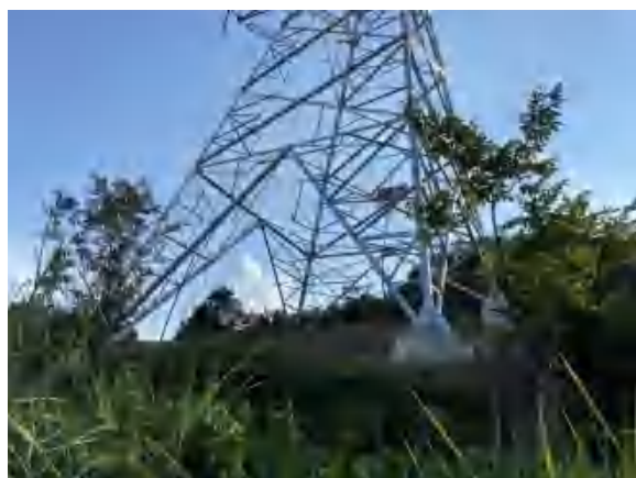
220kV 万松 4P23 线、万阳 4P24 线 #8 塔基恢复
