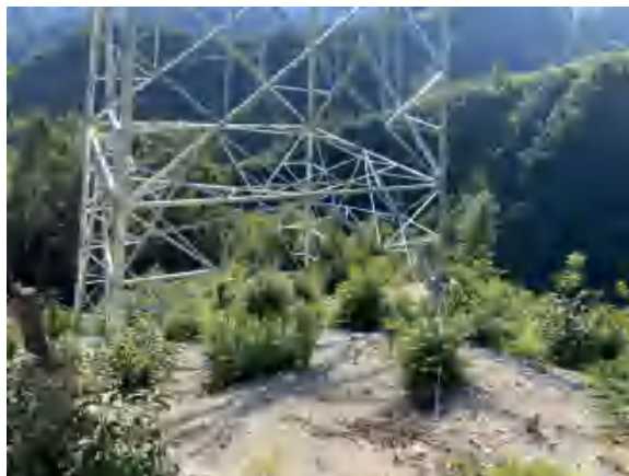
220kV 剑松 4PA5 线、剑阳 4P46 线 #67 塔基周边绿化恢复
