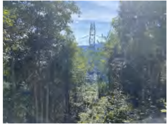
220kV 剑松 4PA5 线、剑阳 4P46 线 #66 塔基周边绿化恢复
