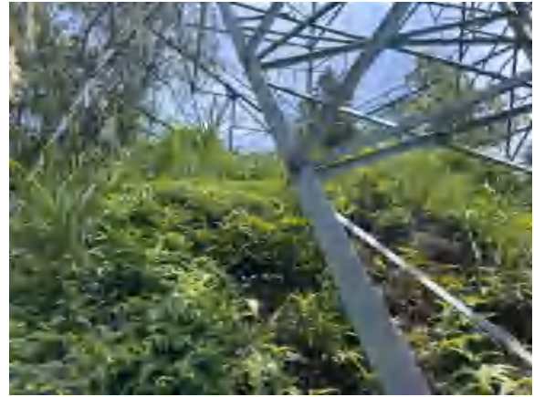
220kV 川睦 4PA3 线、川田 4PA4 线 #89 塔基恢复
