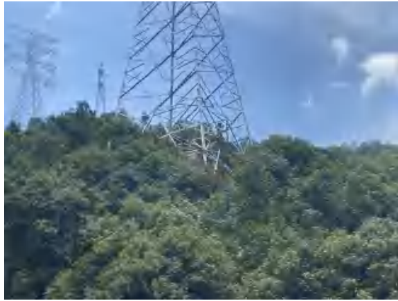
万象~鹤溪π入睦田变 220kV 线路工程 换接工程线路沿线植被恢复
