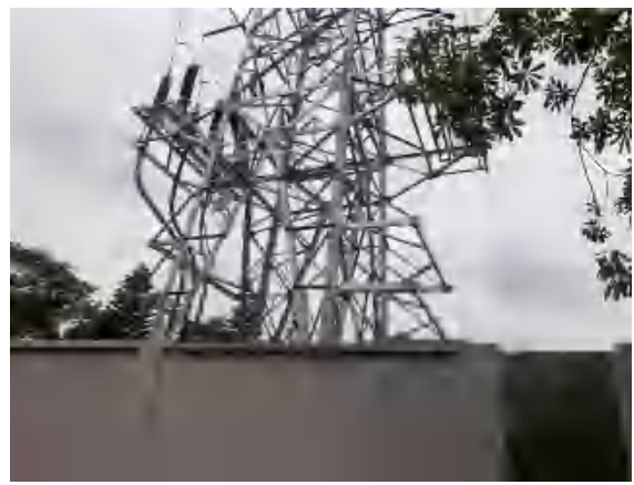
新建电缆上线塔基 T 接 110kV 迎新乙线 点
