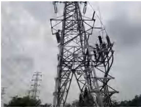
新建电缆上线塔基 T 接 110kV 迎潭化甲线 点
