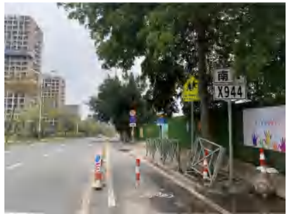
电缆沟路面硬化
