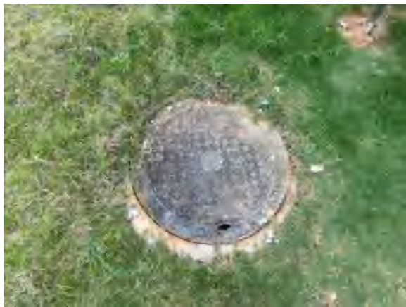
站内污水井盖
