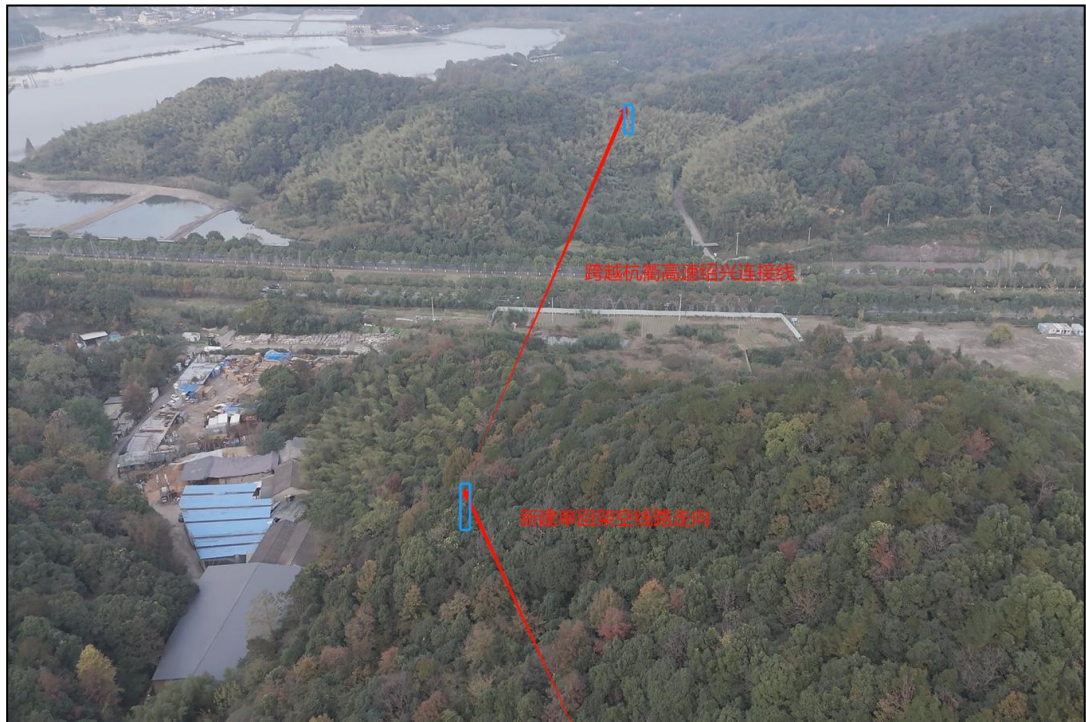
图 3-1 本工程架空线路沿线环境现状
